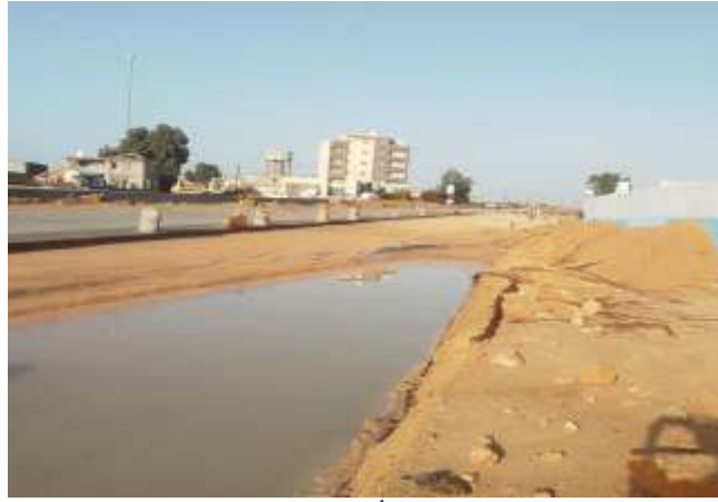
شكل (6) يبين تعرض تربة الأساس الحبيبي للغمر بمياه السيول
