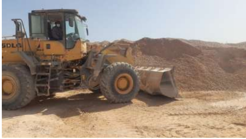
شكل (11) جزء من عملية الخلط وضبط التدرج في موقع التشوين
