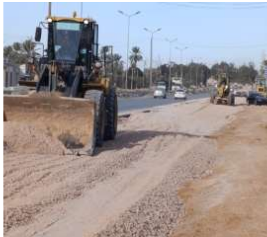
شكل (9) البدء بأعمال إزالة تربة الأساس الحبيبي من مسار الطريق
