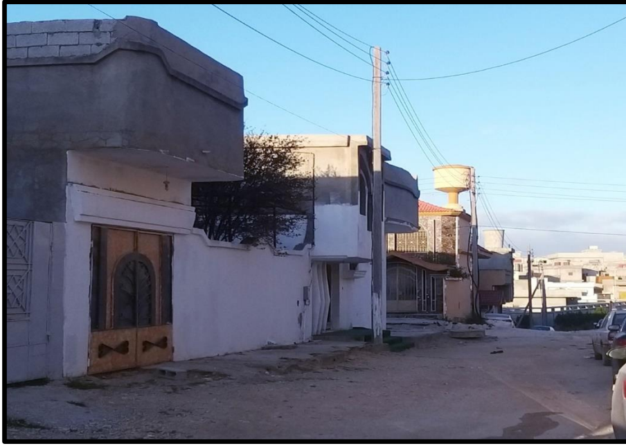
الشكل (5) تشابك اسلاك الكوابل الهوائية بمدينة القبة
