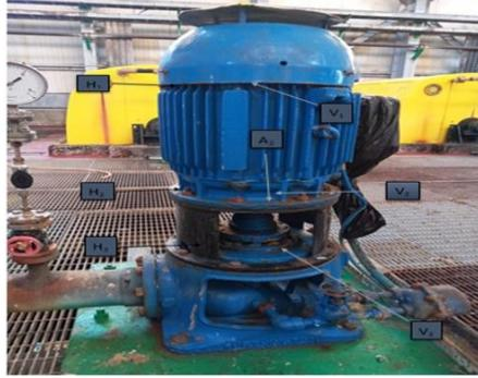
شكل 7. يوضح Vertical centrifugal pump
