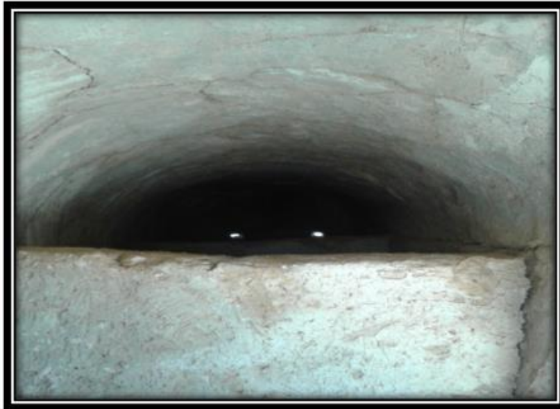
شكل 14 يوضح احدى الغرف الموجودة في القاطع (ج). المصدر: تصوير الباحثة 2023.
