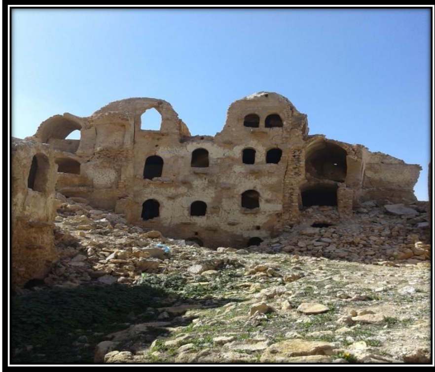
شكل 10 يوضح المظهر الخارجي للقاطع (ب). المصدر: تصوير الباحثة 2023.
