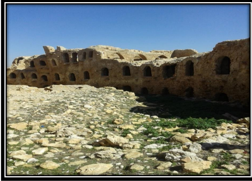
شكل 13 يوضح المظهر الخارجي للقاطع (ج). المصدر: تصوير الباحثة 2023.
